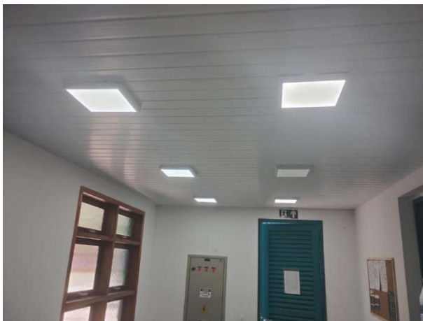
Figura 54 Troca de lâmpadas queimadas (Antes)
