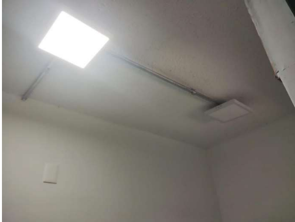
Figura 52 Troca de lâmpadas queimadas (Antes)
