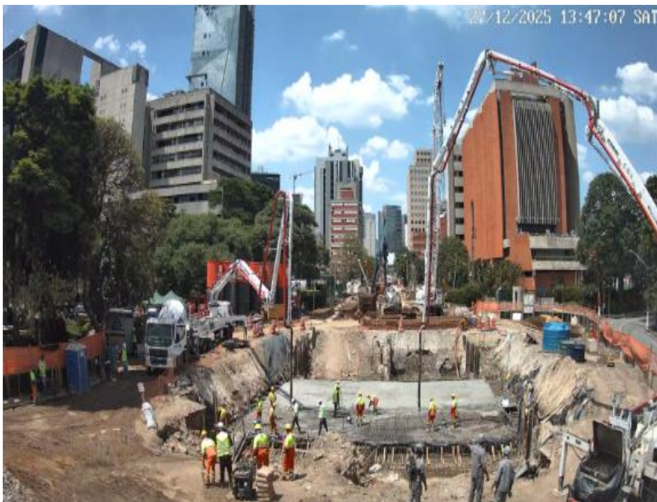
Concretagem da laje superior do túnel, trecho 2A
