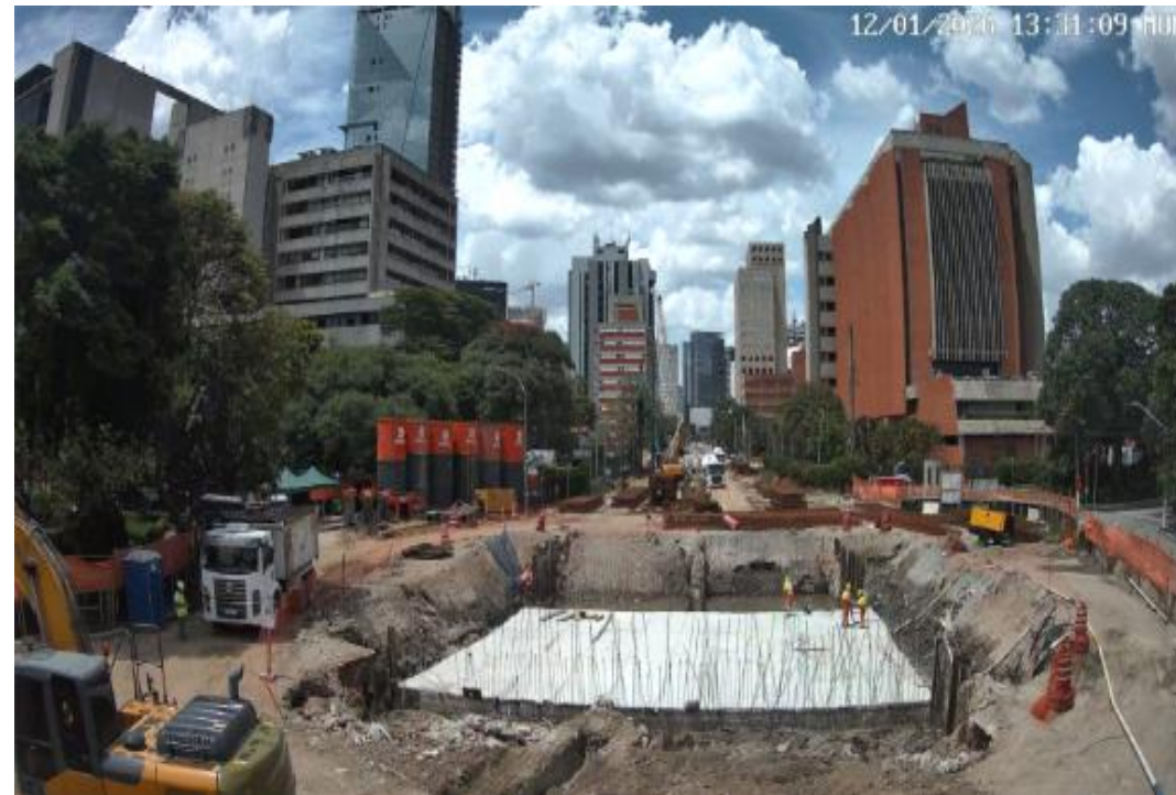
Laje superior do túnel após cura úmida, trecho 2A
