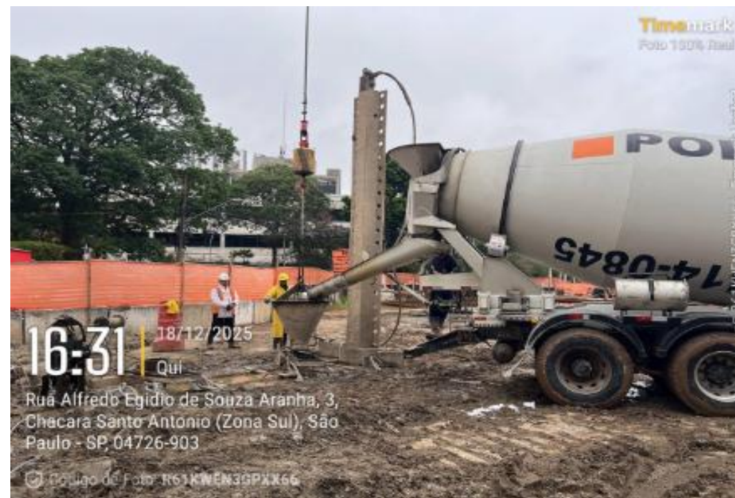
Concretagem da lamela.
